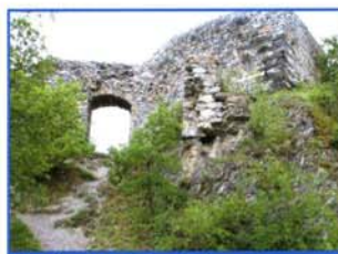
Porte principale du bourg. Photo A. Antonini
